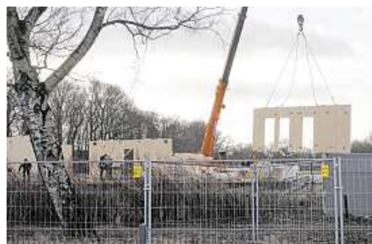
Am Haken eines großen Krans schweben die Fertigbauteile für den Neubau derzeit auf die Baustelle.
